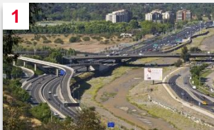
1 ACCESO COSTANERA SUR ORIENTE (1.0 km)
